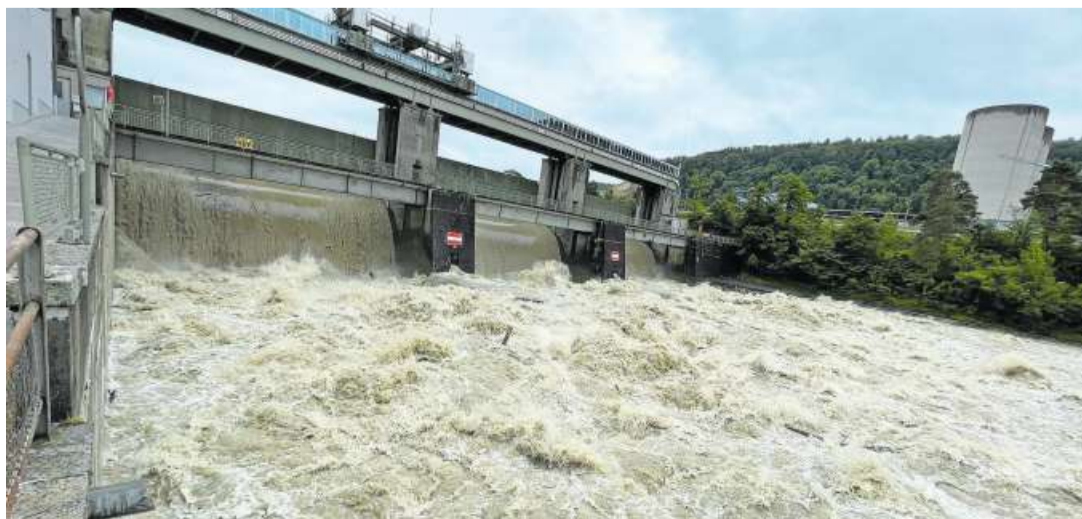
Beim Kraftwerk Reckingen fliesst viel Wasser ab.
